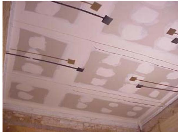
Photo A - Plafond suspendu en panneaux de fibres minérales Photo B - Plafond suspendu en plaques de plâtre
